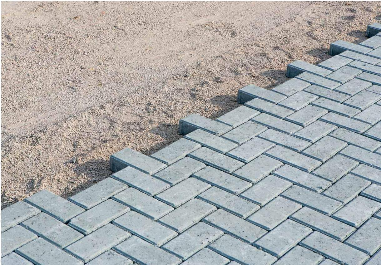
Figura 60: Exemplo de pavimento intertravado.
