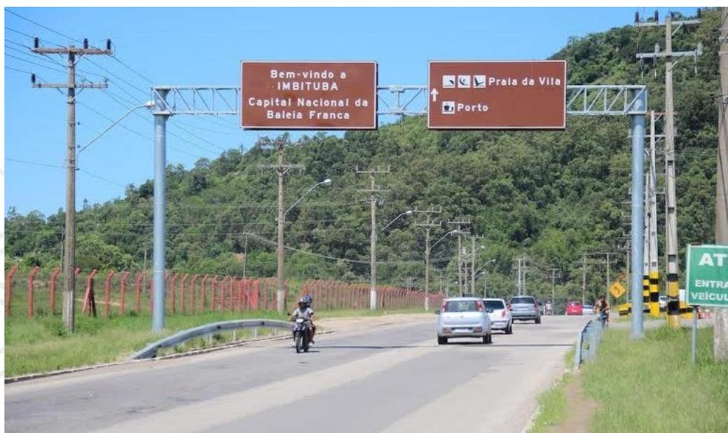
Figura 99: Exemplo de sinalização indicativa em placa em pórtico metálico.
