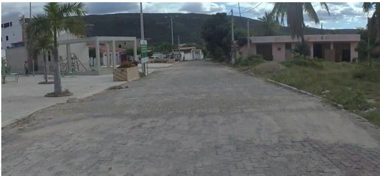
Figura 16: Pavimento intertravado na R. Torquato Braz. Fonte: Autoria própria.
